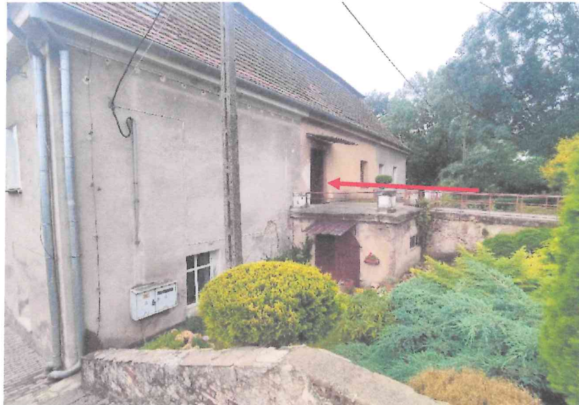
wejście do budynku
